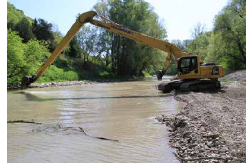
Obnovenie Karloveského ramena Foto: Andrej Devečka
