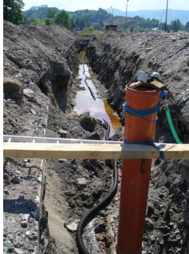
Sanácia znečistenej podzemnej vody pomocou sanačného drénu Foto: Jaromír Helma
